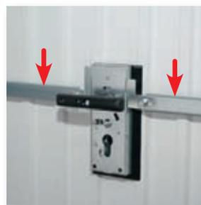
La porte basculante **DWM<sup>®</sup>** est équipée d'un verrouillage en 2 points latéraux indépendants du sol et totalement inaccessibles de l'extérieur. Elle peut même être équipée d'un point de verrouillage complémentaire au sol ou au linteau\* (options).
